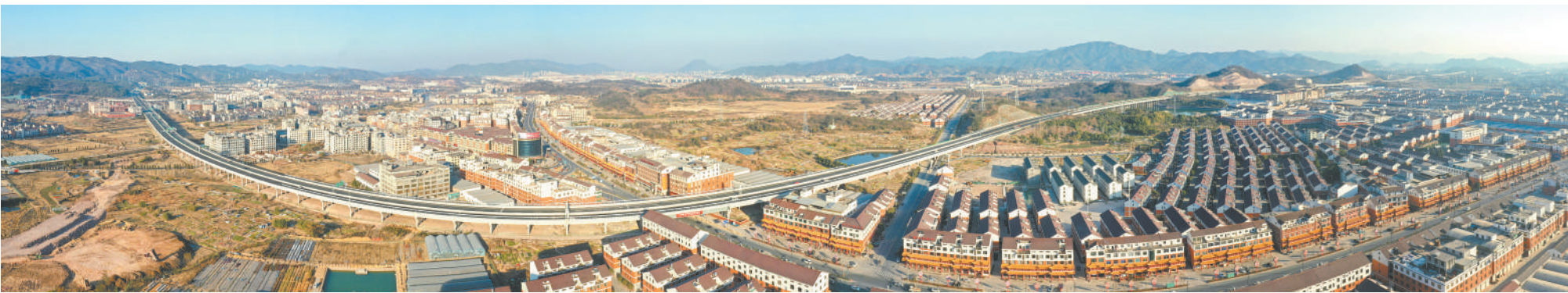
图为义东高速花园段风貌。
